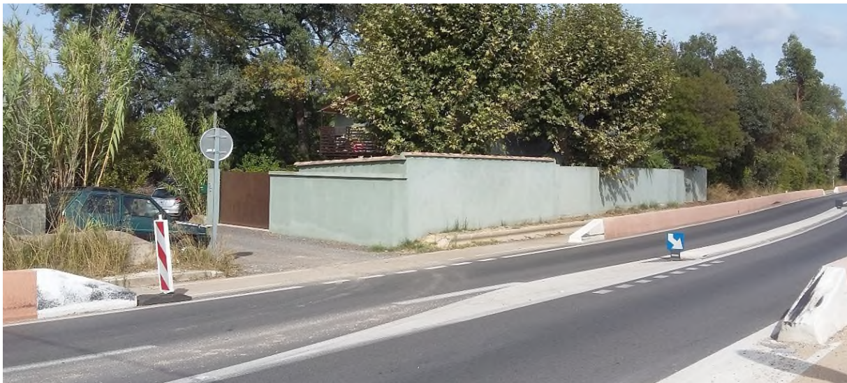
Accès existant (chemin de Saint Augustin) sur la RD98
